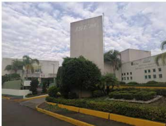
Fachada del Hospital Municipal Temascaltepec "José María Morelos y Pavón".
